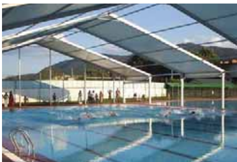
Piscina Municipal de El Tiemblo (Ávila)
