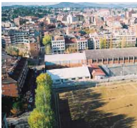
Piscina Municipal de Sant Cugat (Barcelona)
