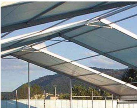
Piscina Municipal de El Tiemblo (Ávila)
