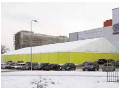
Paneles aislantes de chapa rellenos de espuma de poliuretano
